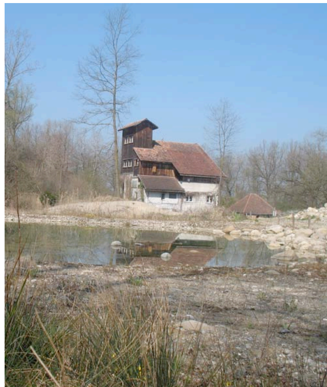
Der alte Kiesturm im Zentrum des Naturlehrgebietes. Auf dem grossen Dach wird die Solaranlage gebaut. Die Balkenkonstruktion im oberen Teil (Holz) wird geschützt und das Dach erneuert.
